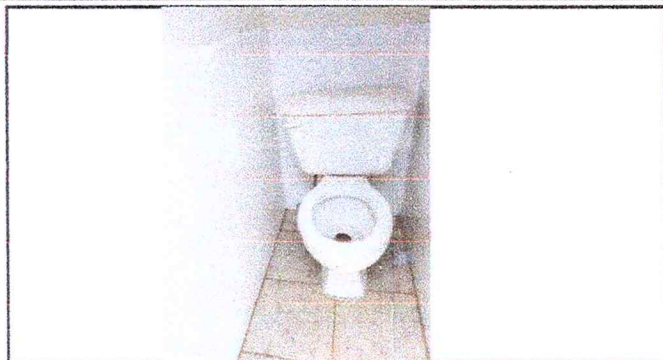
Foto1: Instalación de azulejo en pared, instalación de piso cerámico antideslizante.
