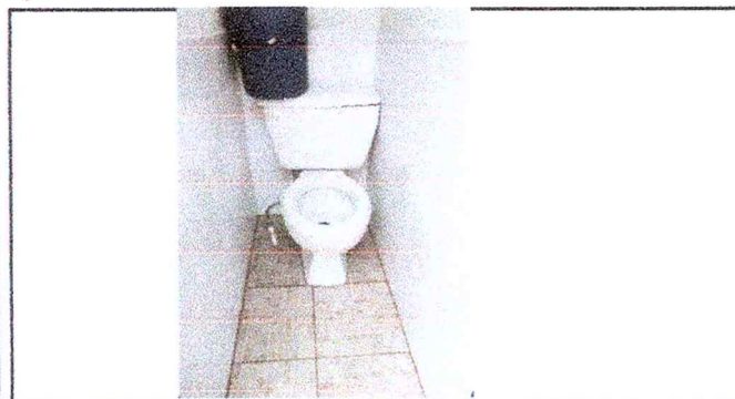
Foto 3: Instalación de azulejo en pared, instalación de piso cerámico antideslizante.
