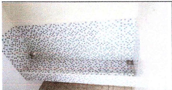
Foto 6: SUSTITUCIÓN DE PISO CONCRETO POR CERÁMICO Y CERNIDO POR AZULEJO de 2 Mingitorios
