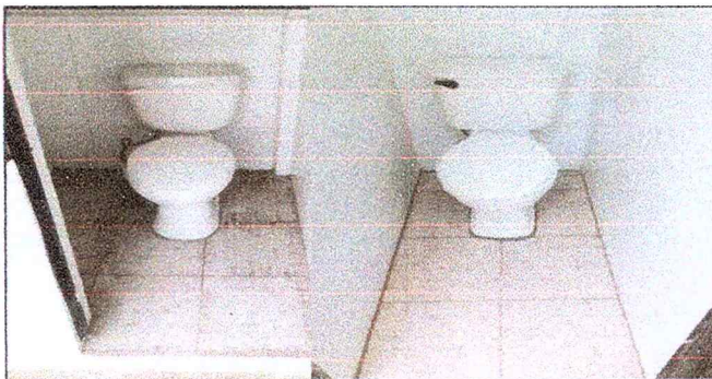
Foto 5: SUSTITUCIÓN DE PISO CONCRETO POR CERÁMICO Y CERNIDO POR AZULEJO de 8 sanitarios
